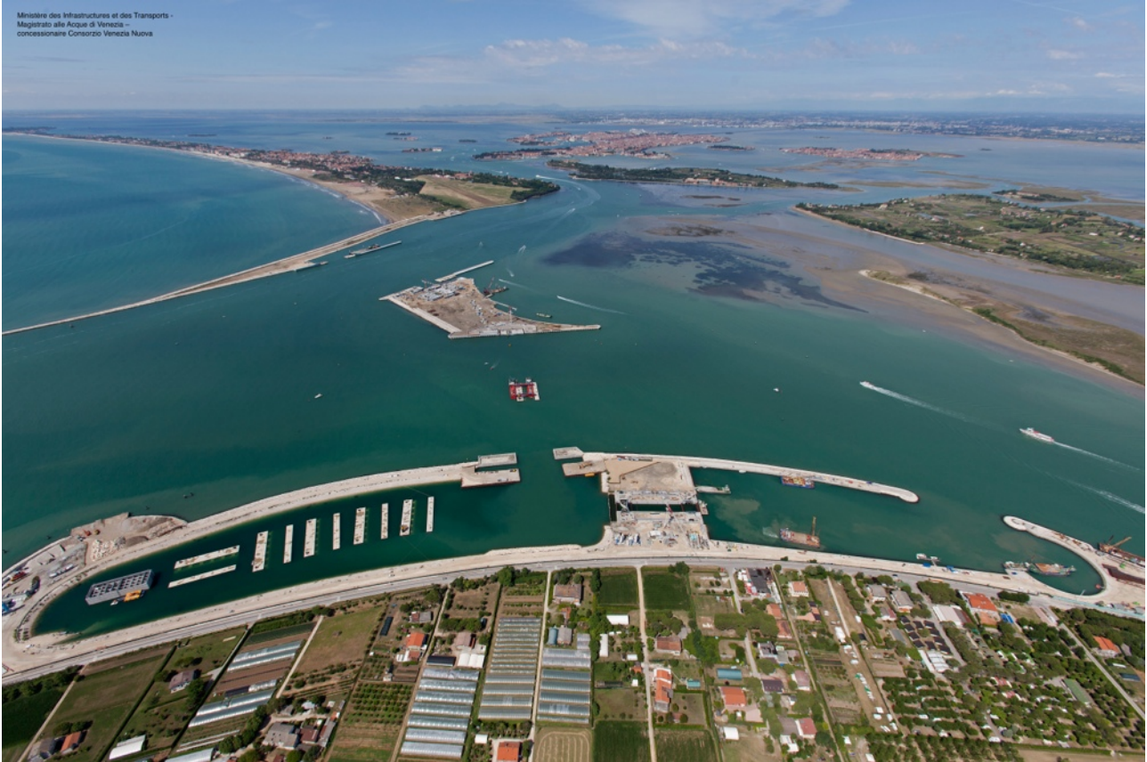
Photo du chantier du MoSE dans la passe de Lido, juin 2012 Source : Magistrato alle Acque, Venise
