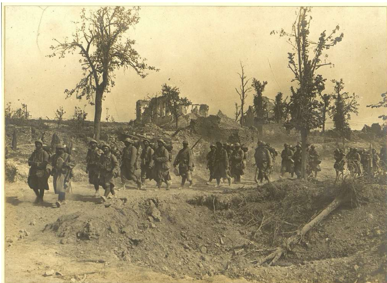
Troupes françaises revenant de la première ligne et passant devant les ruines de l'église de Faÿ, juillet 1916.
