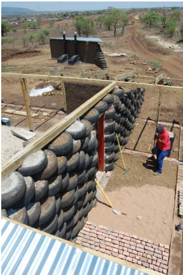
Briques déclassées, murs en pneus et charpente en palettes assemblées.
