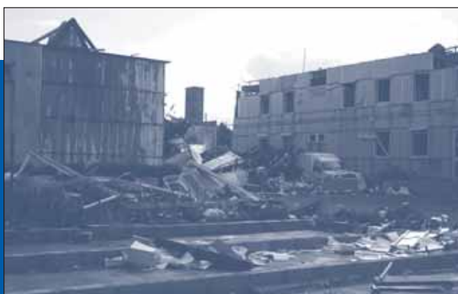
Lycée Placide Courtoy à Hautmont après le passage de la tornade du 3/08/2008
