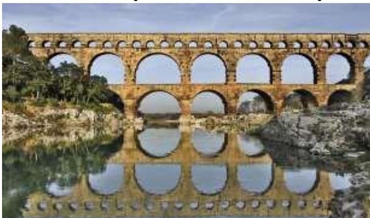
Pont du Gard , 1er siècle après JC H = 48m, L = 360m
