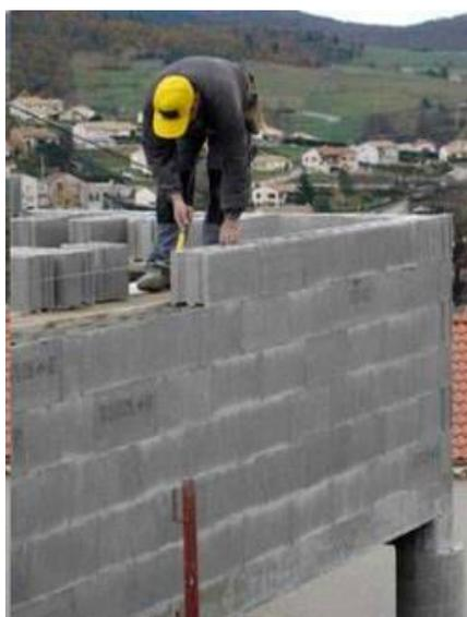
On peut aussi utiliser la ficelle pour poser des briques ou des parpaings en ligne droite.
