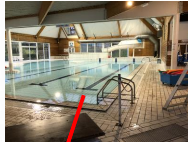
Petit bassin (profondeur max : 1,30m)
