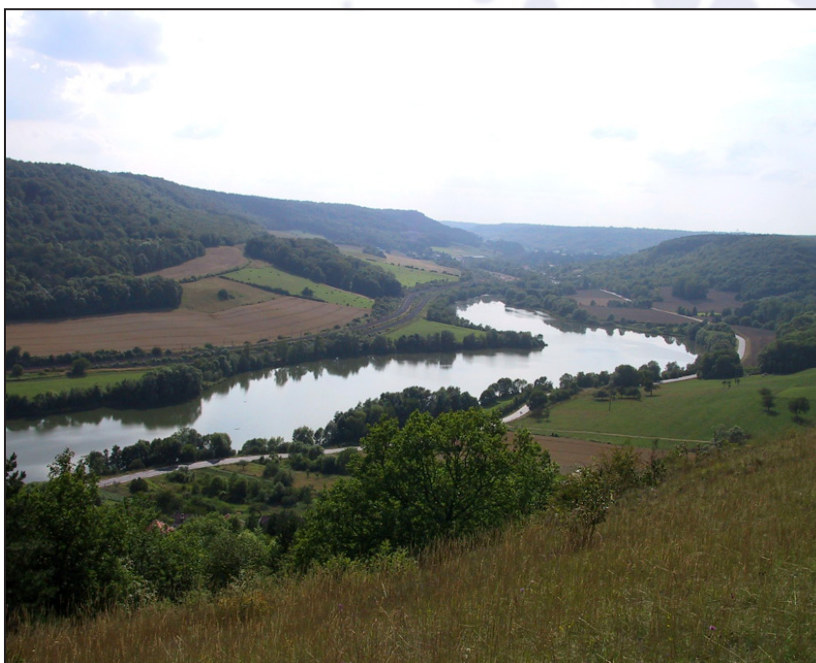
Crédit PnrL La retenue d'Arnaville sur le Rupt-de-Mad, à partir de laquelle s'effectue l'alimentation en eau de l'agglomération de Metz
